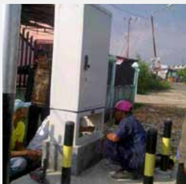
Pemasangan/Instalasi ODC di pinggir jalan
