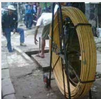
Penarikan kabel Fiber Optic dan Subduct Feeder
