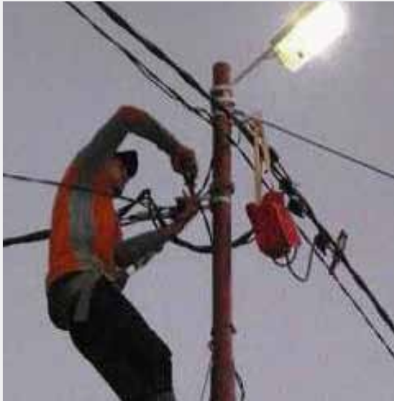
instalasi PLTS di Papua barat
