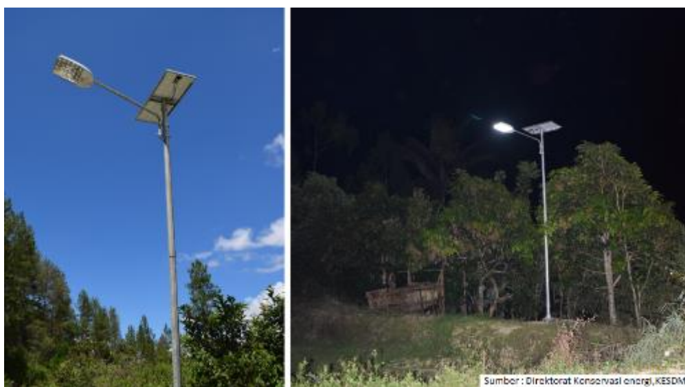
Gambar III-23 PJU LED dengan PV Support
