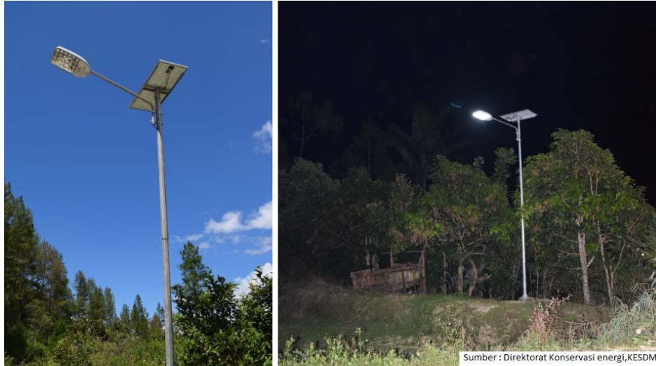
Gambar IV-22 PJU LED dengan PV Support
